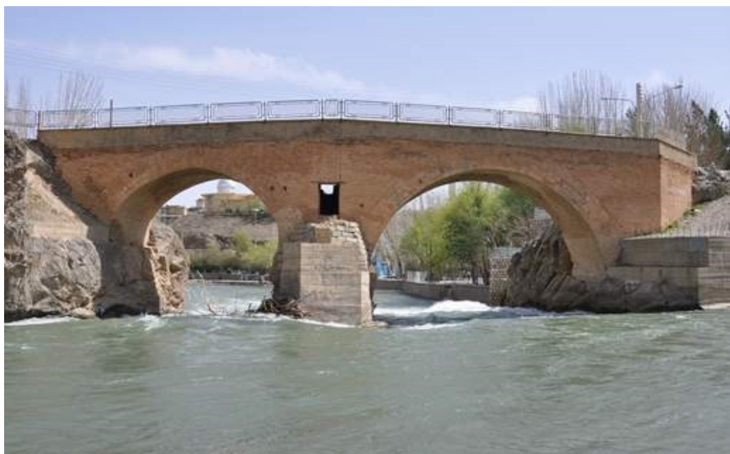
نمای پشت از پل زمانخان نَفر
